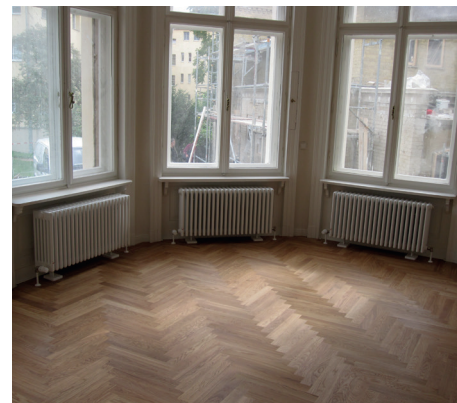
Aufarbeitung von Schmuckheizkörpern
