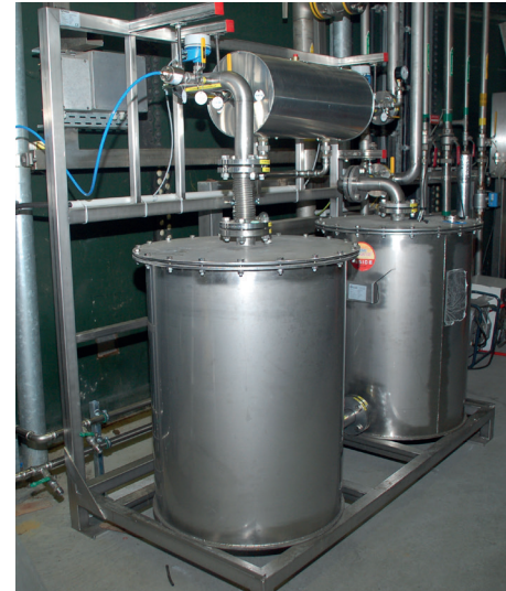
Klärgasreinigungsanlage
