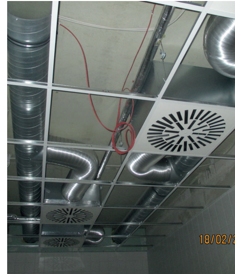
Lüftungsinstallationen im Spülbereich
