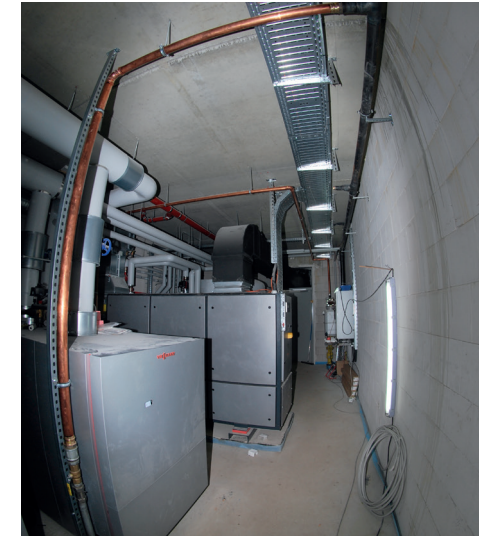
Enge in der Heizzentrale
