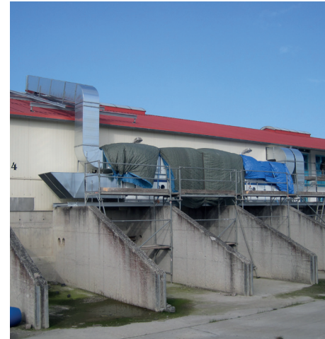
Lüftungszentralanlage im Bau vor Umhausung
