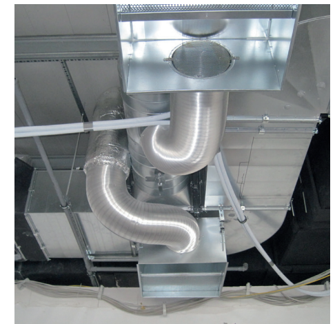
enge Platzverhältnisse während Montage
