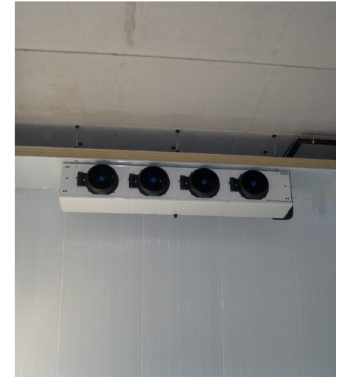
Deckeninnengerät zentraler Gefrierraum im Raum
