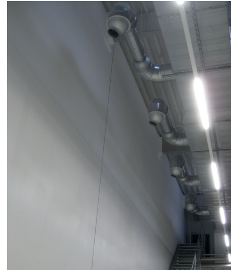
Installation von Hauptkanal und Weitwurfdüsen
