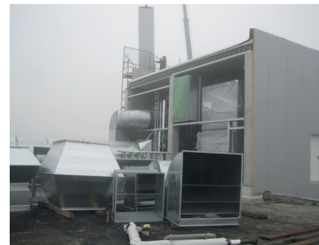
Installation von Hauptkanal und Weitwurfdüsen
