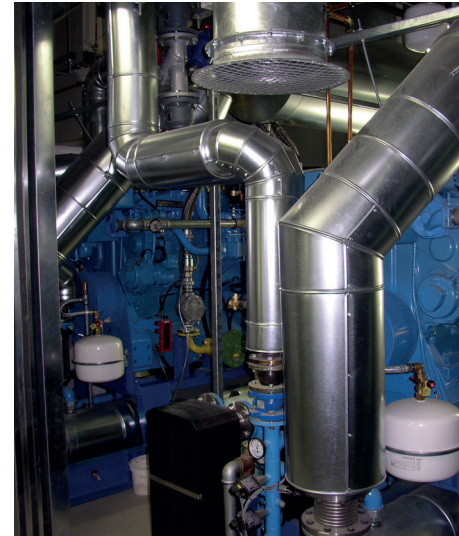
Enge im Maschinenraum
