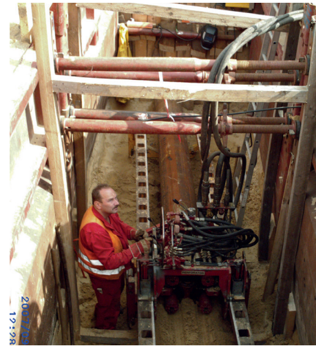
Einbringen eines Schutzrohres im Pressbohrverfahren
