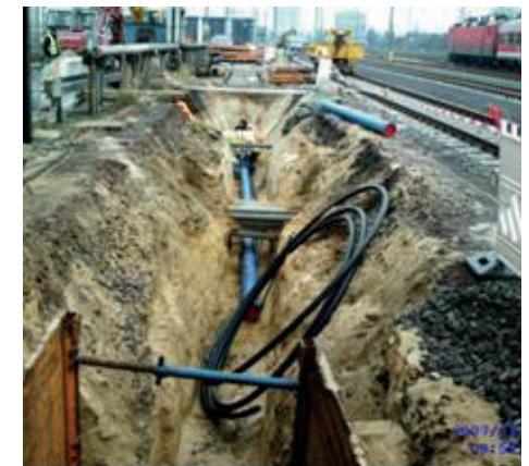
Zum Einbau vorbereitetes Schieberkreuz
