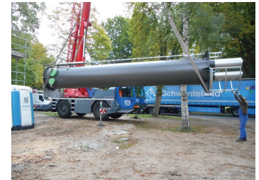
Aufstellung des Schornsteins
