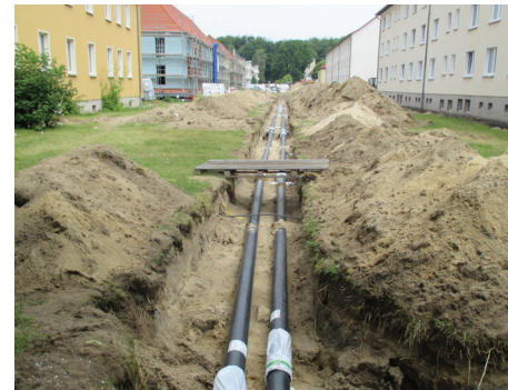
Verlegung der Fernwärmetrasse
