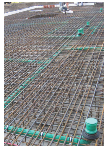
Verlegung der Grundleitungen
