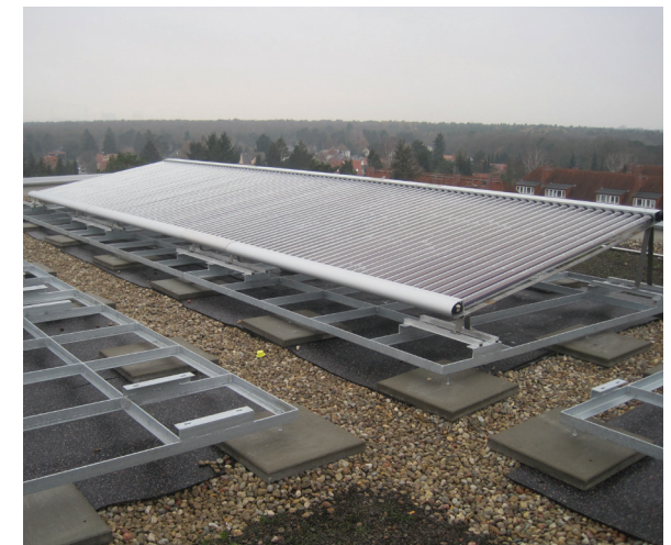
Solarthermie-Kollektoren während der Dachmontage
