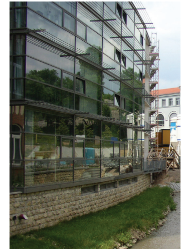
Fertige Fassade mit Tiefgaranzufahrt
